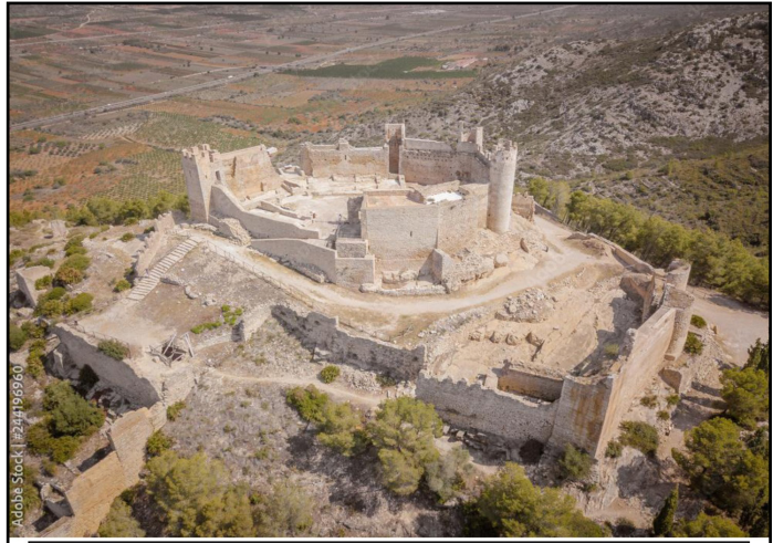
Ilustración 13. Fotografía que nos muestra los restos de triple recinto que aún hoy permanecen en la Bailía de Xivert.
